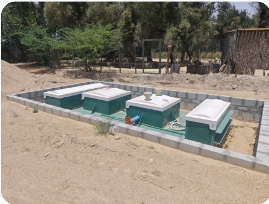
STP 60m 3 مثبت على قاعدة خرسانية STP 60m 3 installed on a concrete base
