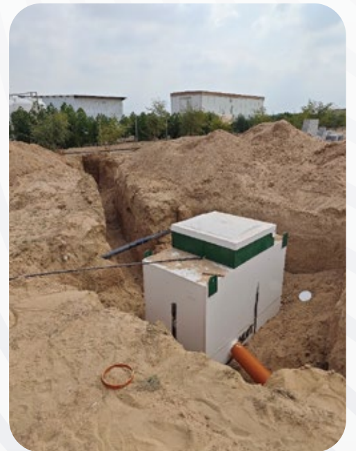
STP 60m 3 مثبت على قاعدة خرسانية STP 60m 3 installed on a concrete base
