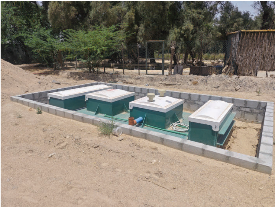
STP 60m 3 مثبت على قاعدة خرسانية STP 60m 3 installed on a concrete base
